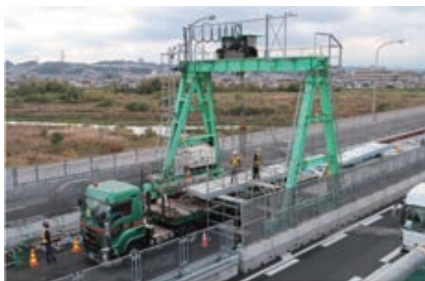
多摩川橋床版取替工事状況
