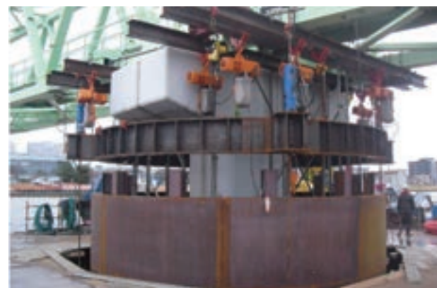
白山下水道耐震補強工事状況(STEP工法)
