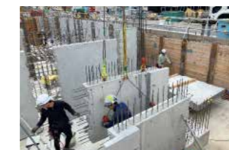
PCa壁施工状況
