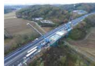
前田川橋 床版架設状況
