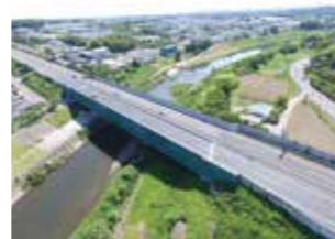
釈迦堂川橋 施工完了
