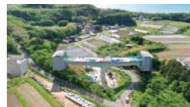
川袋小川橋架設状況
