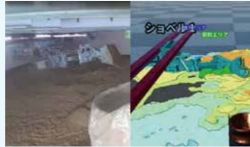
図-1 自動運転システムによる掘削 (左：地下空間、右：地上可視化画面) 提供：株式会社DeepX
