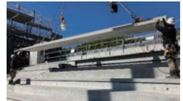
PC段床版の施工
