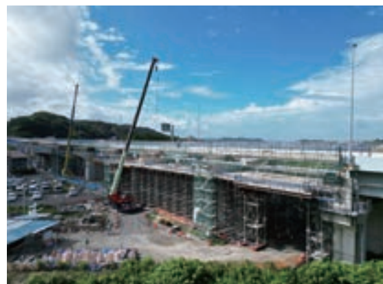
1号橋施工状況
