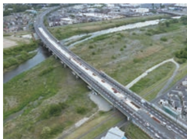
中央自動車道 多摩川橋床版取替工事全景
