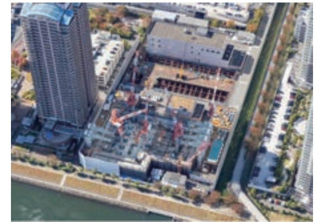
江東ポンプ所ケーソン工事
