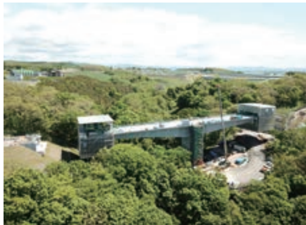
神山川橋上部工事
