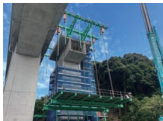
2号橋張出架設状況
