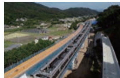
工事名称 令和4年度 23号蒲郡B P金野第5橋鋼上部工事 発注者名 国土交通省 中部地方整備局
