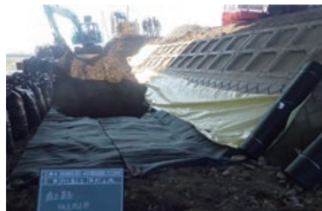
シート養生の実施
