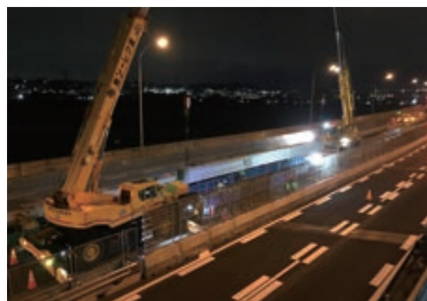
中央分離帯部 PC桁架設状況
