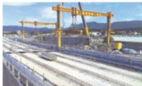
架設門構による主桁架設状況
