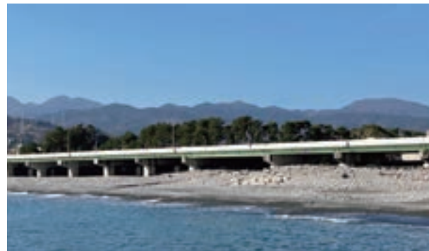
萬丈橋塩害対策工事
