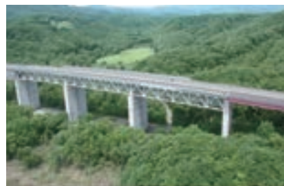
工事名称 道央自動車道 メップ川橋東地区原形復旧工事 発注者名 東日本高速道路(株) 北海道支社
