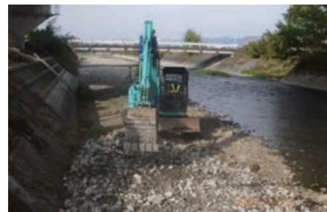
割栗石の敷き均し
