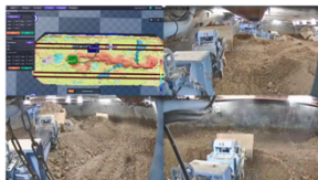
ケーソン工法無人化掘削システム
