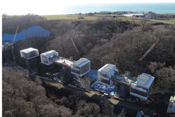
大狩部橋上部工事
