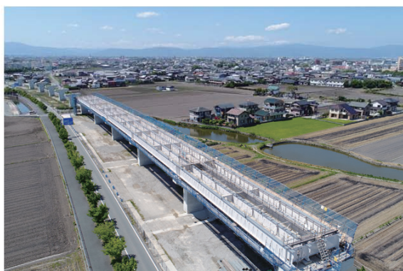
福岡208号大川高架橋上部工(P34-P39)工事
