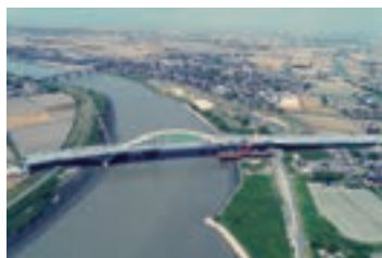
早津江川橋上部工事
