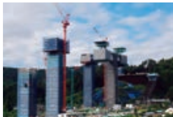
柳島高架橋工事
