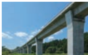
土木工事 常磐道木戸川橋下部工事
