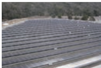
西脇太陽光発電所
