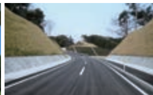
南作/青井線道路改良工事
