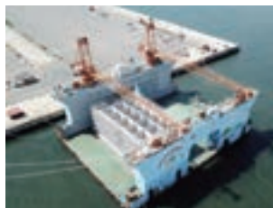
港湾工事 三崎防波堤延長工事
