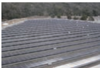
西脇太陽光発電所
