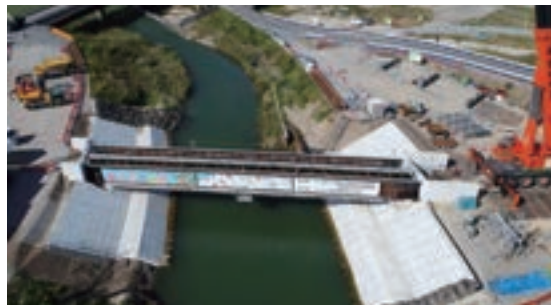
架設完成状況
