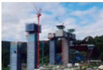
柳島高架橋工事
