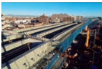
春田4高架橋鋼上部工事
