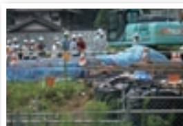
大きな建設機械
