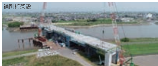
補剛桁架設
