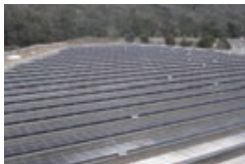
西脇太陽光発電所
