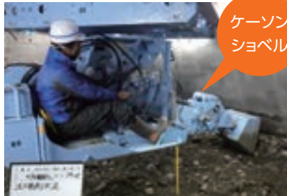
沈下掘削
