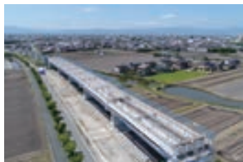
福岡208号大川高架橋上部工(P34-P39)工事
