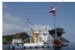
コンクリート打設状況
