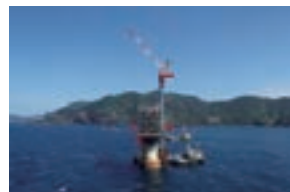
P4橋脚全景
