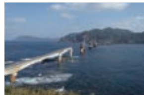
蘭牟田瀬戸架橋全景
