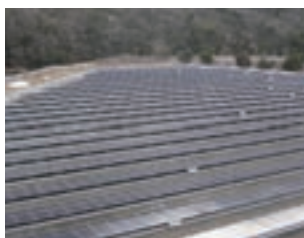
西脇太陽光発電所
