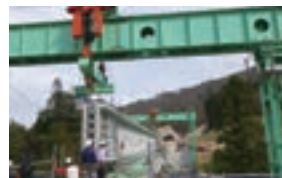
広前橋主桁架設
