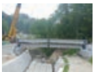
石田川橋フレン架設
