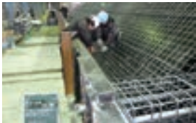
鉄筋組立状況
