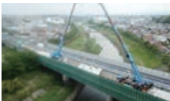
釈迦堂川橋 架設
