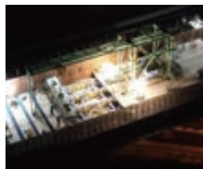
夜間架設の様子
