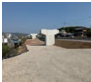
工事完成(全景)
