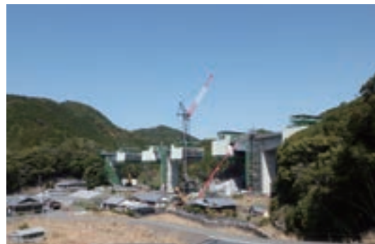
移動式作業車 (ワーゲン)
