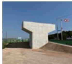
工事完成(近景)
