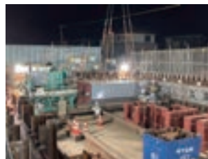
現場据付状況
