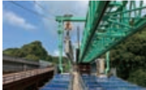
小野橋主桁架設
