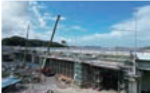
1号橋施工状況
