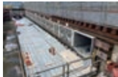
現場据付完了
