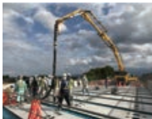
PC床版間詰め部施工
