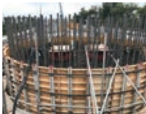
型枠組立工
