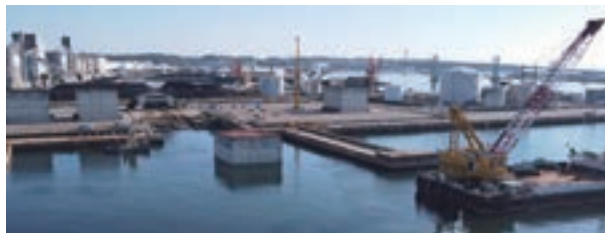
ケーソン進水
