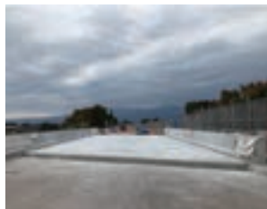
床版取替完了
