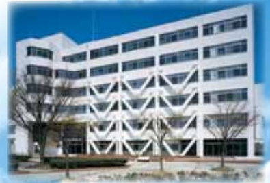
豊橋技術科学大学電気情報研究棟(愛知県)
