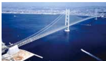
明石海峡大橋(兵庫県)
