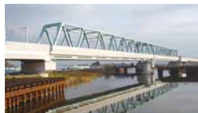
成田高速線印幡捷水路橋りょう(千葉県)
