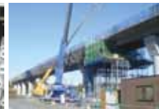
接合部コンクリート打設状況
