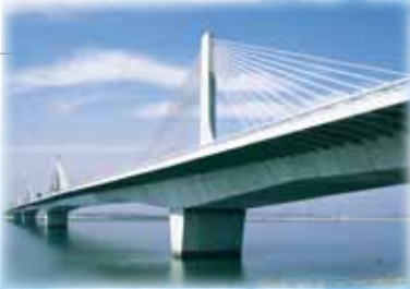
第二名神高速道路木曾川橋(三重県)
