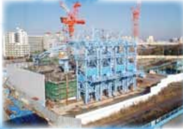
小松川第二ポンプ場(東京都)
