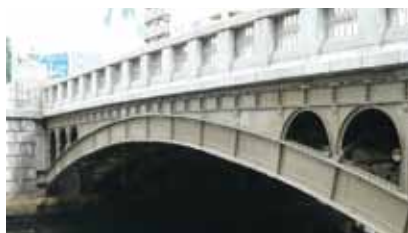
岩井橋(愛知県) 大正12年施工[土木学会選奨土木遺産]
