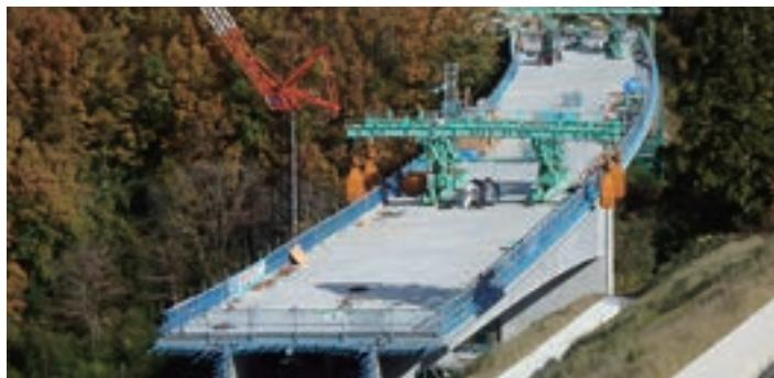
張出施工終了・移動作業車解体
