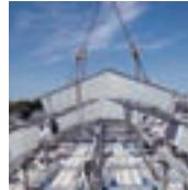
本建物は教会の聖堂棟で、祭壇および聖堂スペースから構成されています。外観は山形屋根、内部は教会建築に多くみられるアーチ構造でデザインされており、本工事ではこのアーチ状の屋根と丸柱の架構をプレキャストPC造により施工しました。
