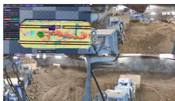
ケーソン工法無人化掘削システム
