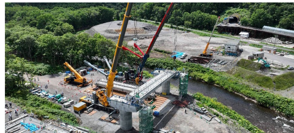
北海道新幹線、南一線橋りょう 初採用されたプレキャストPC単純U形桁を施工
