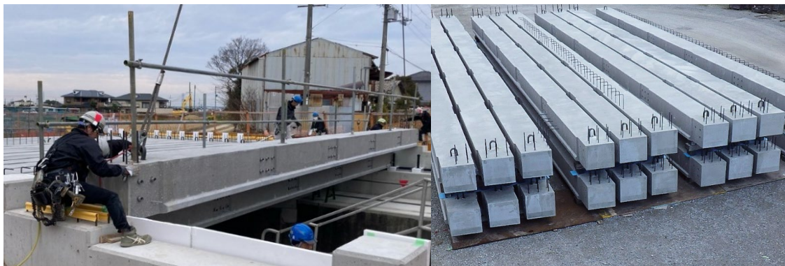
初適用工事におけるプレキャストPC桁の仮設状況
