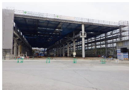
工事写真(ライン棟)
