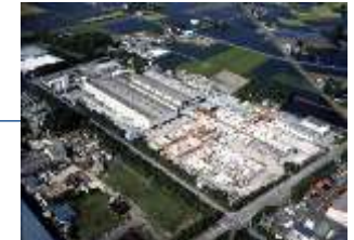
関東工場 | コンクリート製品 @栃木県真岡市
