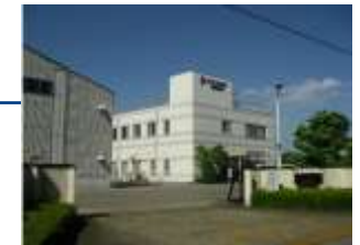
技術研究所 @栃木県真岡市
