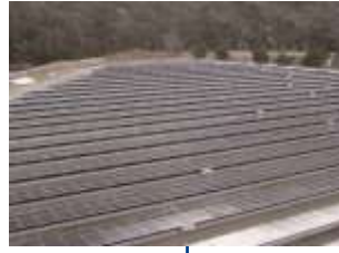
太陽光発電 @兵庫県西脇市
